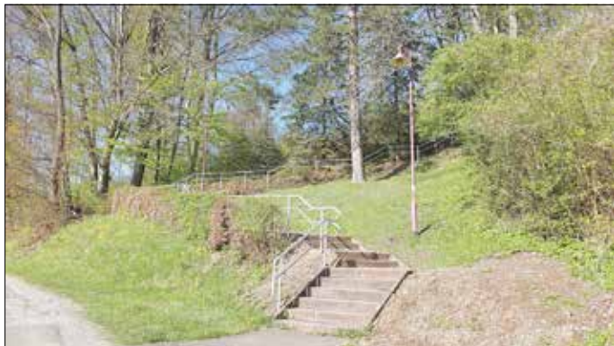
Treppenanlage zum Festplatz Am Heuberg in Wendehausen Foto: Ulrike Thon
